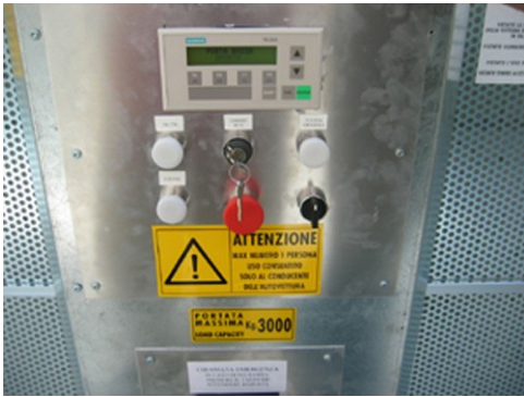
Photo: Panneau de commande embarqué En option: Affichage en temps réel sur écran de messages d'informations sur la manœuvre en cours
